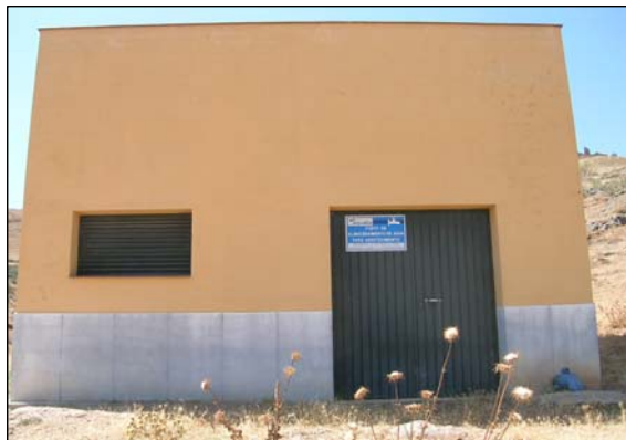
ESTACIÓN DE BOMBEO DEL PANTANO.
